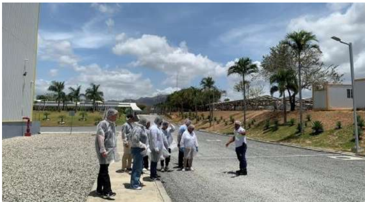
La planta de Café Durán en Coclé, se destaca por la implementación de prácticas responsables como la recolección de agua y el uso de paneles solares.
